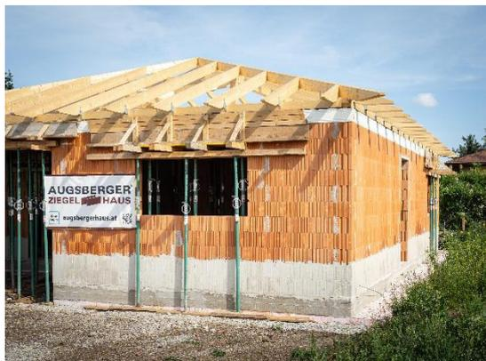
**Bildtext:** Exakt 1.890 Porotherm Plan E Ziegel wurden für den Rohbau angeliefert.
