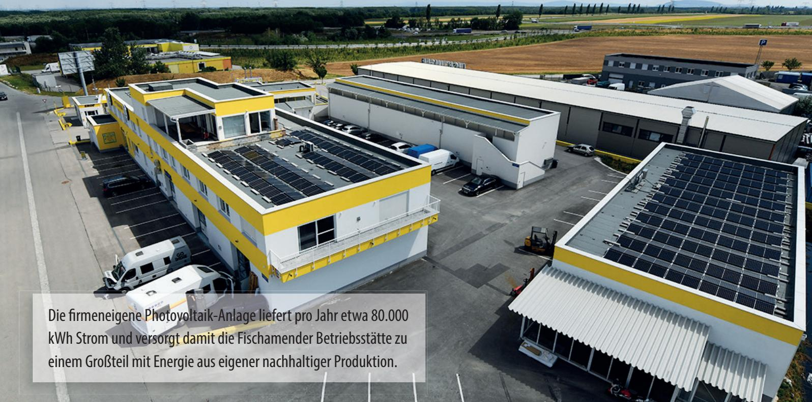
Die firmeneigene Photovoltaik-Anlage liefert pro Jahr etwa 80.000 kWh Strom und versorgt damit die Fischamender Betriebsstätte zu einem Großteil mit Energie aus eigener nachhaltiger Produktion.
